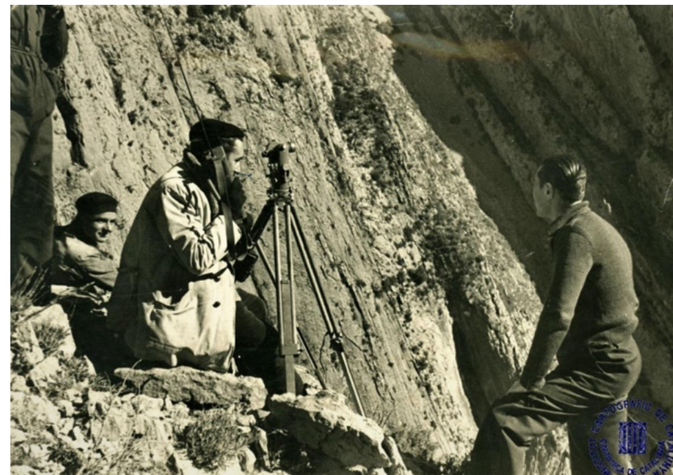
Figura 2. Josep M. Puchades realitzant treballs topogràfics amb un teodolit al pantà d'Escales, l'any 1949. Fons fotogràfic Pau Vila, RF. 47773
