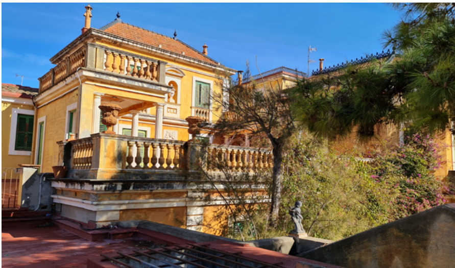
Figura 3. Edifici principal interior de Can Travé des de la teulada de la galeria de la casa annexa (Fotografia: Insenser, Morant, Soler, 2023)
