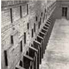
Sant Pere del Bungal, greca (1904). © Arxiu Històric del Col·legi d'Arquitectes de Catalunya.
